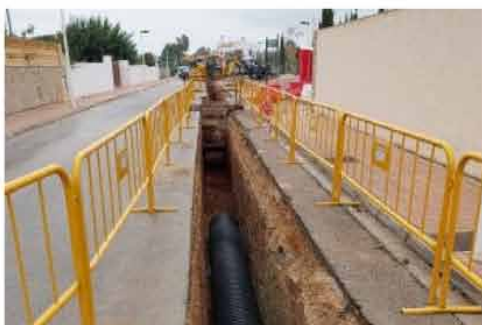
LAjuntament d'Ondara eradica els problemes devacuació de aigües pluvials en la zona de Tossals
